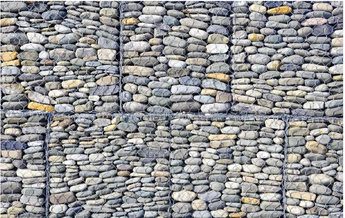
Подпорные стены - это архитектурно-строительные элементы, используемые в организации ландшафтного дизайна и проведении инженерных мероприятий. Главная функция сооружения сводится к укреплению грунта на склонах, откосах и оврагах.
